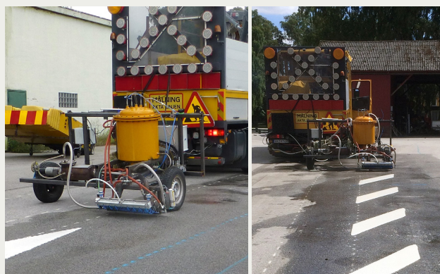
Bild 3B. Exempel på symboler, Trailer monterad möjliggör markering nära dikeskanten.
